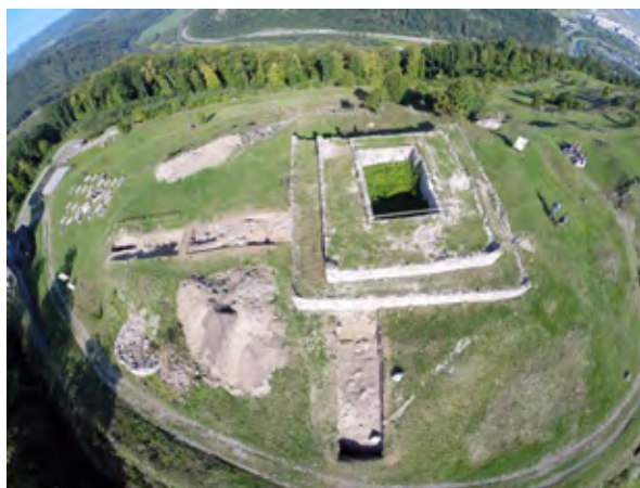
Obr. 5. Pustý hrad vo Zvolene. Horný hrad. Veža komitátneho hradu a pohľad z východu na situovanie sondy 1/2016 a 2/2016.
